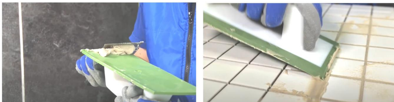
Рис. 39. Заполнение швов затиркой при помощи резинового шпателя
